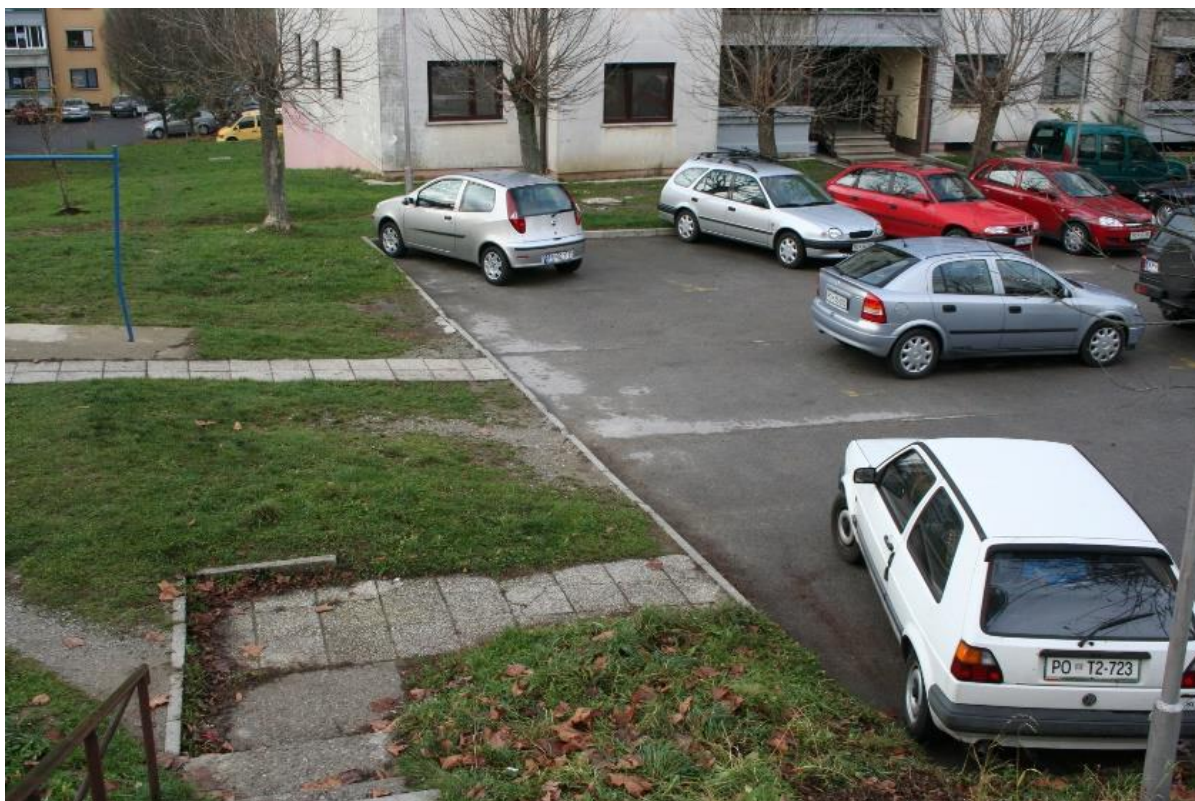
Slika: Primer nepovezanih peš površin. Pešpoti se končajo na veliki parkirni površini brez označitve pasu za pešce, kar pomeni, da slepi in slabovidni ne morejo nadaljevati poti. Poleg tega se pot konča s stopnico, kar pomeni, da je pot neprehodna tudi za ljudi na vozičkih. Takšna pot je lahko nevarna tudi za otroke.
