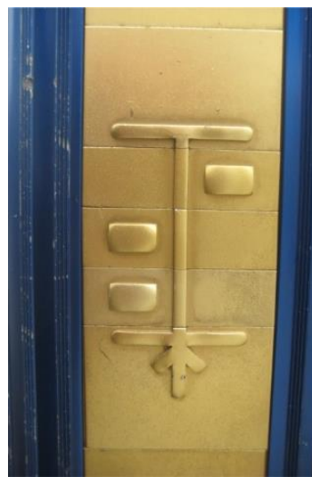
Slika A: Ustrezno opremljen zvočni semafor. Slika B: reliefna puščica na vrhu škatlice semaforja slepi osebi sporoči smer v kateri lahko prečka cesto. Slika C: Na navpični stranici škatlice semaforja lahko slepi otipa postavitev prometnih pasov in dobi občutek o velikosti ceste, ki jo namerava prečkati.
