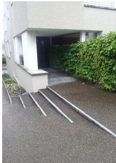
Slika A: Stopnice, ki nimajo primerno označenih robov so zelo težavne za slabovidne in eden najpogostejših vzrokov za poškodbe. Slika B: Z dobro označenimi robovi so stopnice dobro zaznavne vsem.
