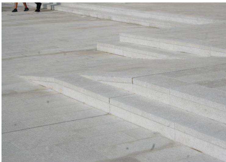
Slika A: Stopnice, ki nimajo primerno označenih robov so zelo težavne za slabovidne in eden najpogostejših vzrokov za poškodbe. Slika B: Z dobro označenimi robovi so stopnice dobro zaznavne vsem.
