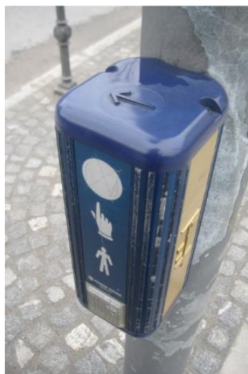
Slika A: Ustrezno opremljen zvočni semafor. Slika B: reliefna puščica na vrhu škatlice semaforja slepi osebi sporoči smer v kateri lahko prečka cesto. Slika C: Na navpični stranici škatlice semaforja lahko slepi otipa postavitev prometnih pasov in dobi občutek o velikosti ceste, ki jo namerava prečkati.
